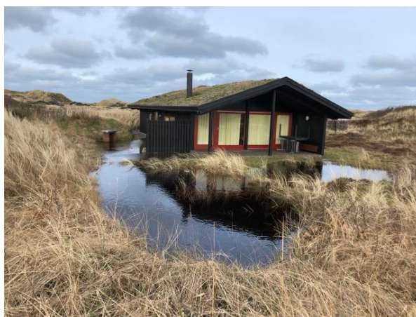
Foto 3 - Opstigende vand ved S. 44
